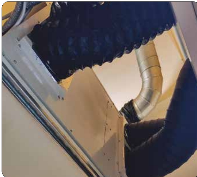
Ejemplo de instalación de un Elfo-18 con tuberías flexibles que permiten una adaptación óptima.
